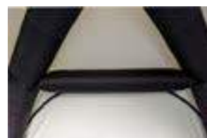
Tube de renfort latéral (pour le vent fort)
